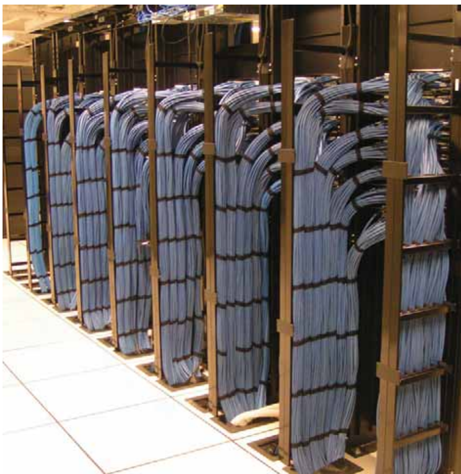
El Sistema iFRAME® de manejo de hardware para red se muestra con el kit de organización de cables en la parte posterior.
